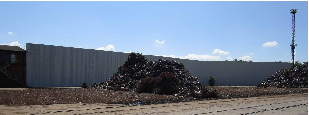
Errichtete Schallschutzwand am zentralen Schrottlager 4/5 (2016)
