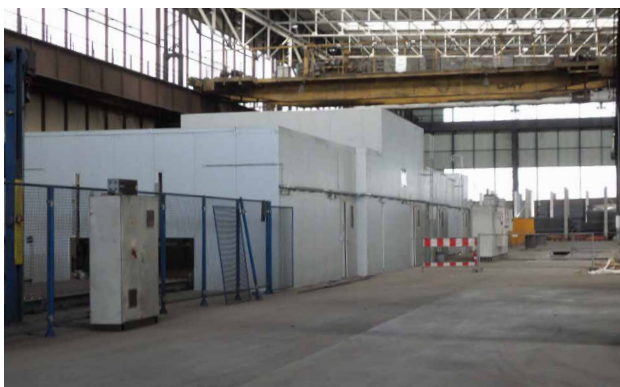
Kapselung Mattenschweißmaschine, Mattenhalle (seit 2015)
