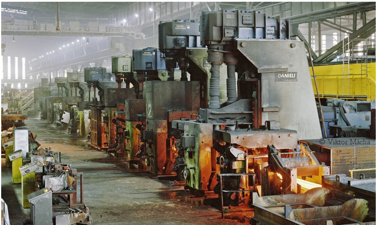
Walzgerüst der Vorstraße im Warmwalzwerk
