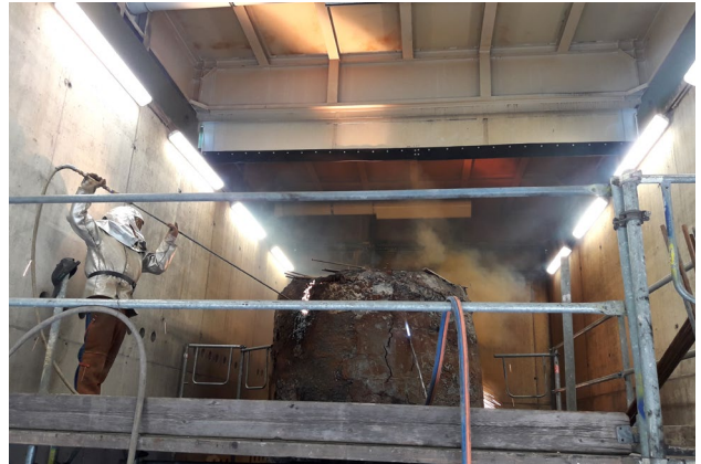
Neue Einhausung Brennerbox mit Anschluss an Entstaubungsanlage im Fallwerk
