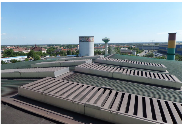
Austausch und Einbau von Zu- und Ablüftern im Dachbereich sowie in den Ost- und Westgiebel des Stahl- und Walzwerkes (seit 2014)
