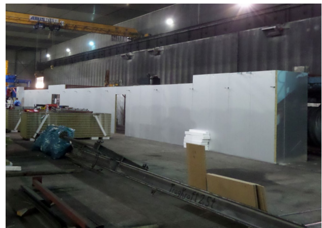
Kapselung Reckanlagen, Drahhalle (seit 2015)
