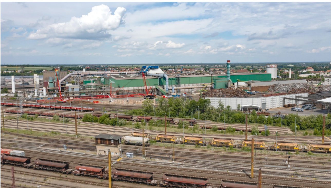
Das hochmoderne Entstaubungssystem des Elektrostahlwerkes der ESF nach Modernisierung der Dachhaube des Schmelzhauses 2022
