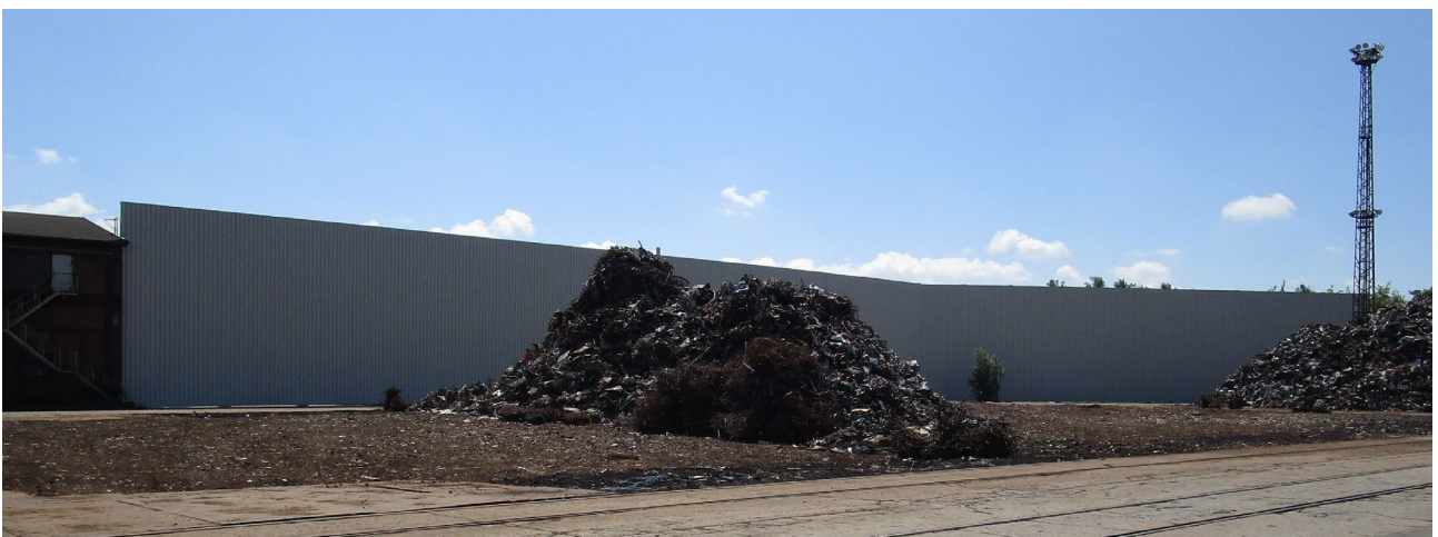
Errichtete Schallschutzwand am zentralen Schrottlager 4/5 (2016)
