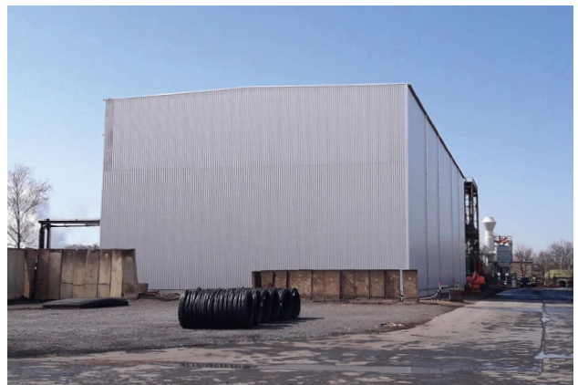
Neue Einhausung für Kippprozess und Abkühlung der E-Ofenschlacke
