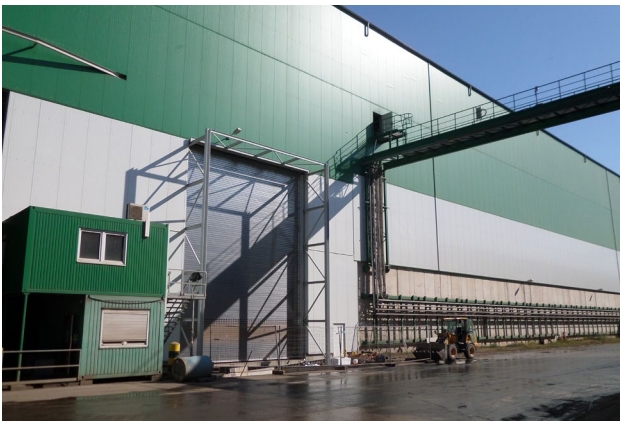
Weitere Schließung der Schrotthalle, Südseite (seit 2015)
