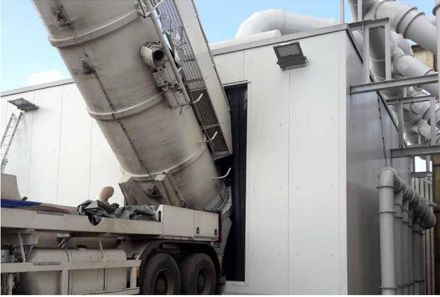
Neue Einhausung für Kippprozess Saugfahrzeuge / Kehrmaschinen
