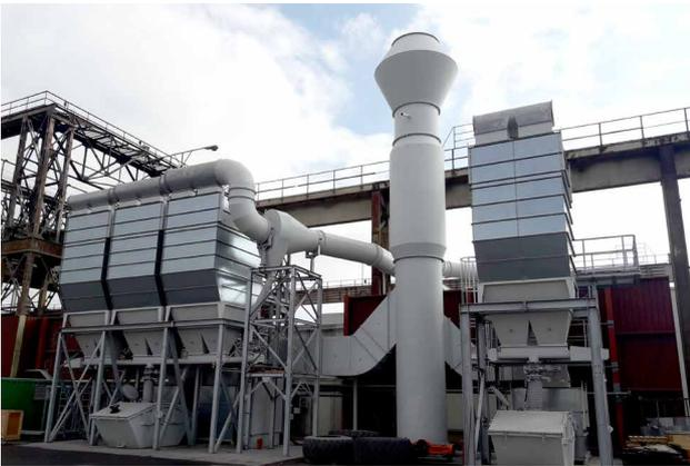
Neue Absaugung und Entstaubungsanlage im Fallwerk
