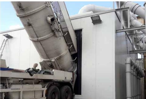
Neue Einhausung für Kippprozess Saugfahrzeuge/ Kehrmaschinen (links) inkl. Absaugung und Entstaubungsanlage im Fallwerk (rechts)
