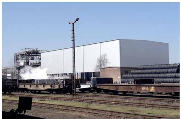
Neue Einhausung für Kippprozess und Abkühlung E-Ofenschlacke
